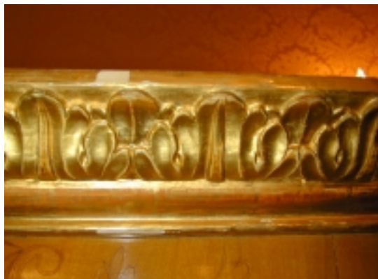
Detail: Rißschäden, aufgezugene Furnierflächen, fehlende Furnierteile und Ausbrüche
