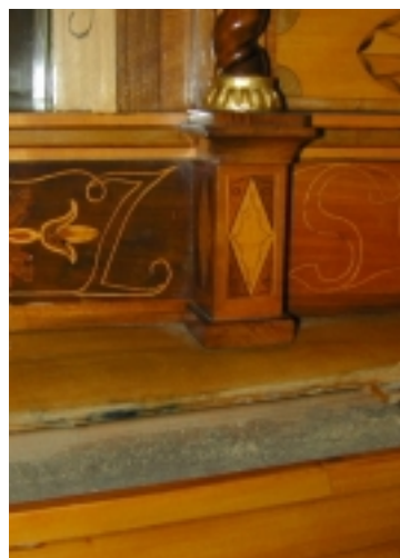
Detail: Fertiggestellte Furnierflächen und Vergoldungsarbeiten, Eingearbeitete Monogramme und Wappen an den Innenflächen
