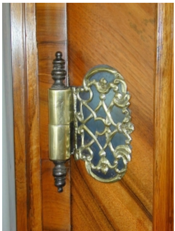
Detail: Fehlstellen wurden mit artgleichem Material ergänzt, danach Farbangleichung zum Bestand Fertiggestellte Oberfläche mit abgeschlossenen Beschlagsarbeiten
