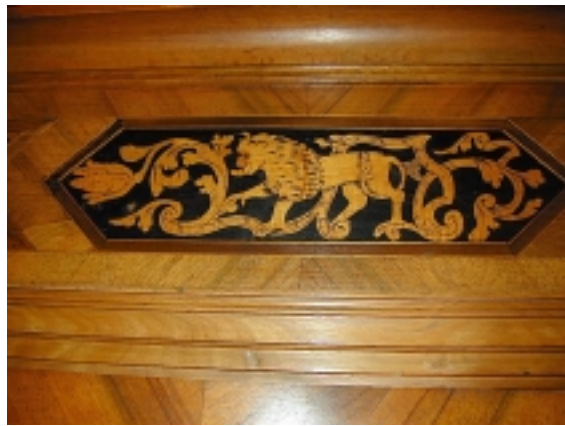
Detail: Fehlstellen bei Furniere, Rißstellen an Oberfläche, abgehobene Furnierflächen von Untergrund
